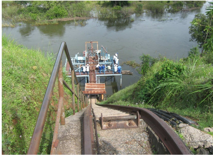
Kafue Raw Water Intake
